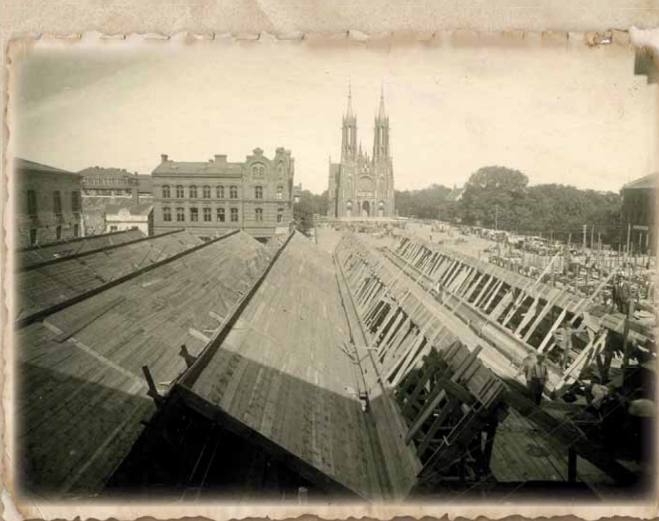
Odbudowa fabryki po 1918 r.
